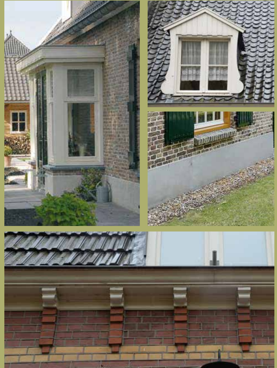
Opvallende dakklijsten, siermetselwerk en afwijkende plinten
